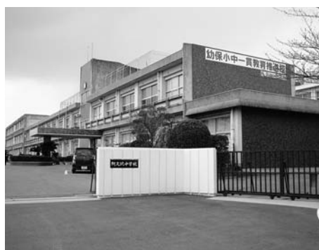
エアコンが設置される中学校
