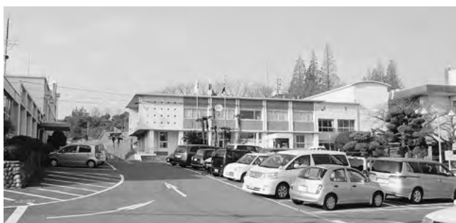
建設予定地・中央公民館南館を解体
