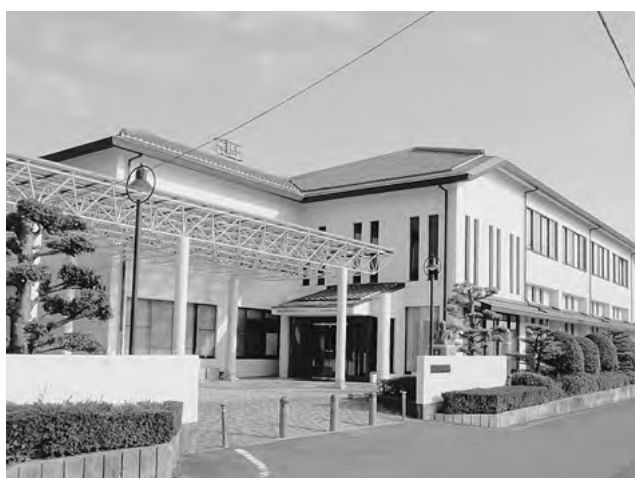
平成元年に竣工したエスペランス丸山
