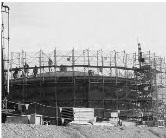
建設中の上水道第3供給点
