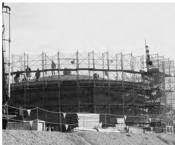
建設中の上水道第3供給点
