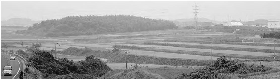
平成13年3月16日換地処分が完了した阿久比南部土地改良事業の現在の様子
