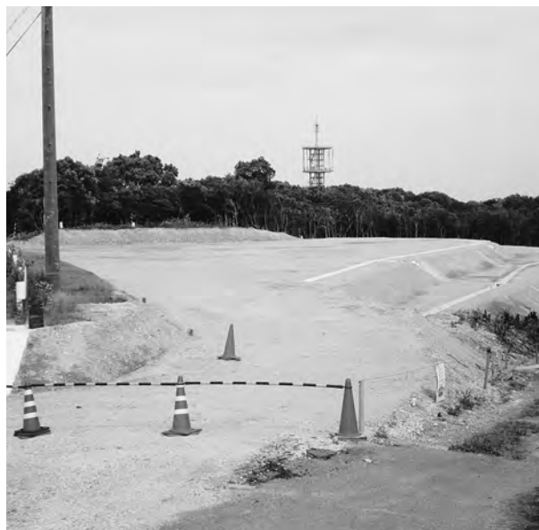
工事中の第3供給点建設地
