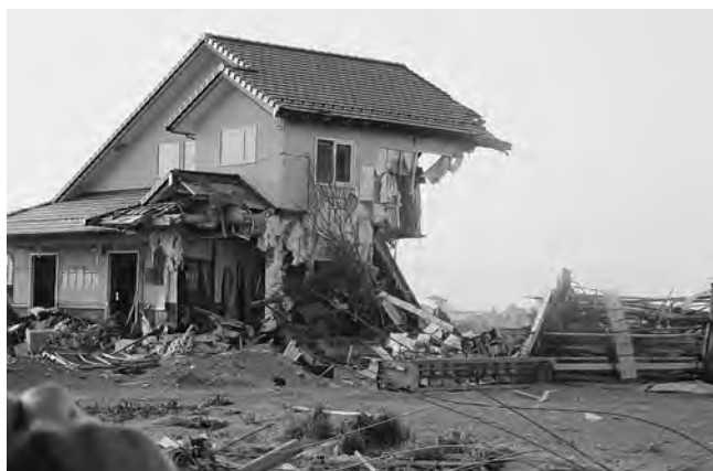
東日本大震災の被害様子
