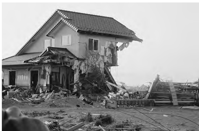
東日本大震災の被害様子
