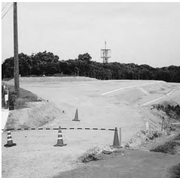
工事中の第3供給点建設地
