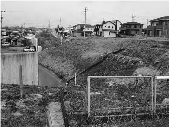
着工が待たれる矢高横川線（宮津地内）
