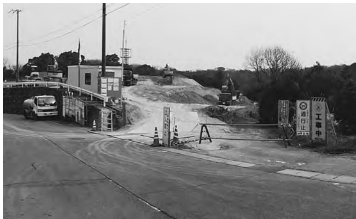
造成中の第三供給点
