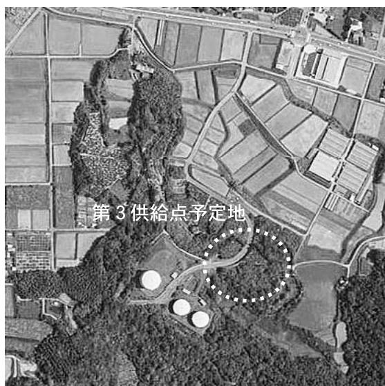
水道タンク予定地（板山地区）
