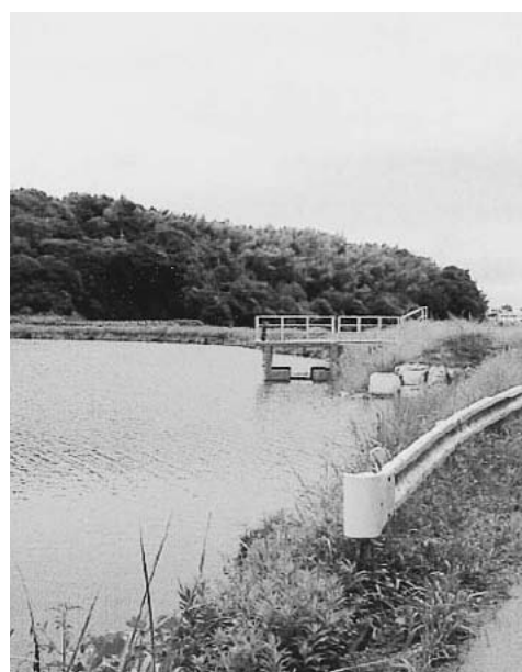
改修中の西狐谷池
