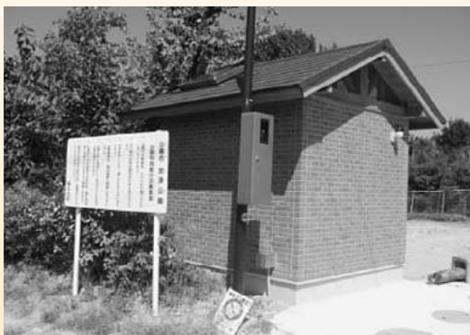
宮津公園トイレを新設
