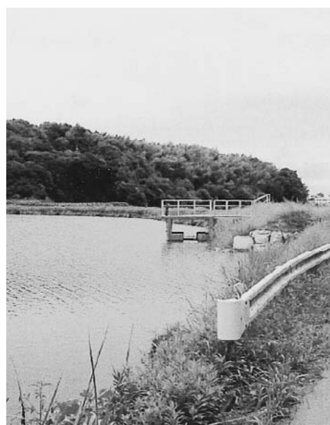
改修中の西狐谷池
