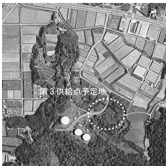
水道タンク予定地（板山地区）
