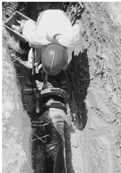
水道管布設工事
