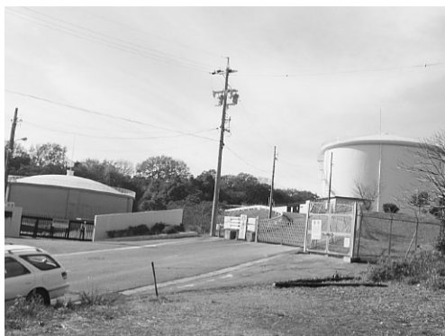
県と半田市の配水タンク
