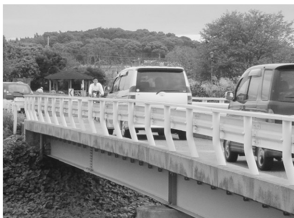
島田橋の現状
