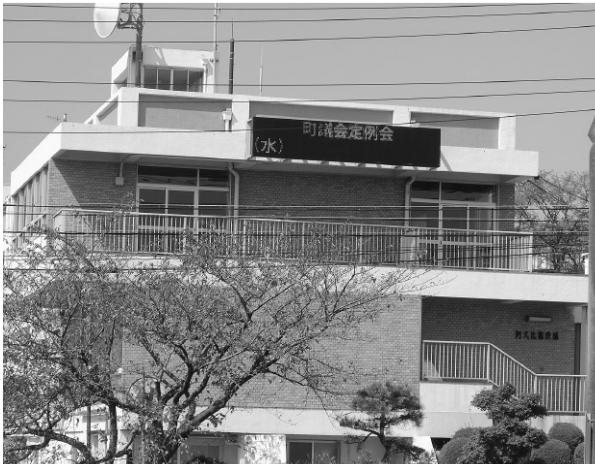
オアシス大橋から見た電光掲示板
