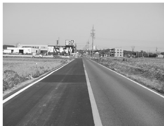
改修された町道113号線
