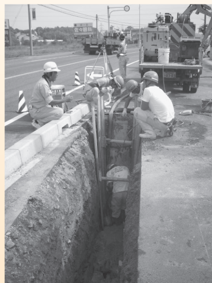
下水道工事(草木地区)
