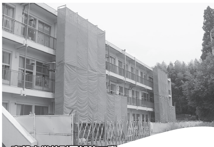
東部小学校耐震補強工事
