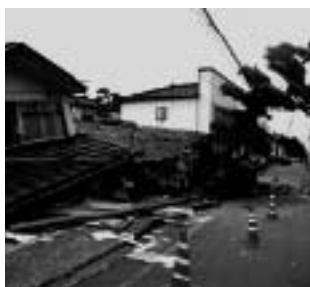
写真提供： 首都大学東京土質研究室
