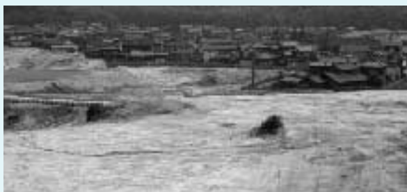
進む宮津板山造成工事
