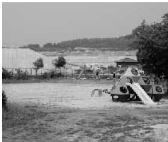
園庭内道路予定地
