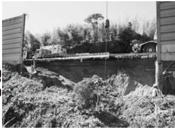
知多半島道路阿久比インター付近のり面
