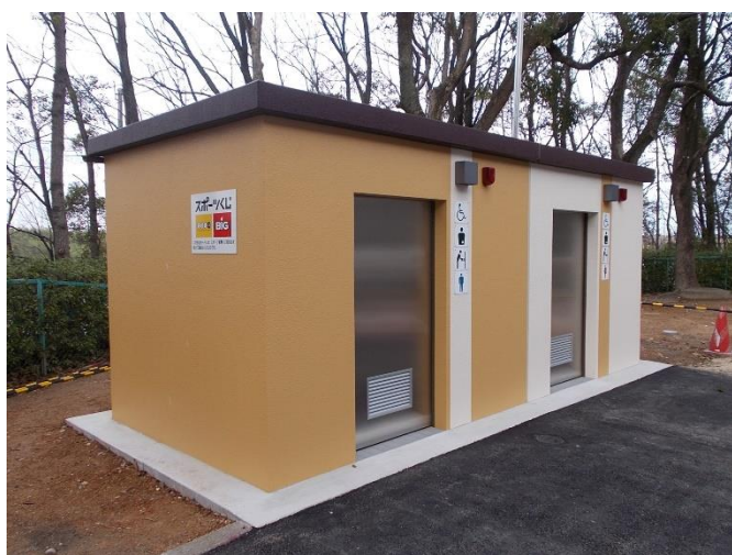
野球場トイレ新設工事
