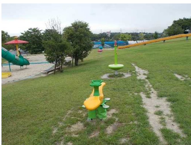
遊具設置工事（ムービング遊具3基、スプリング遊具1基）
