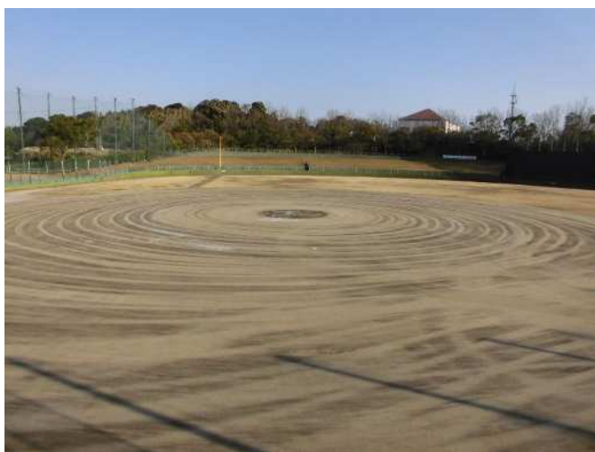
野球場グラウンド整備工事
