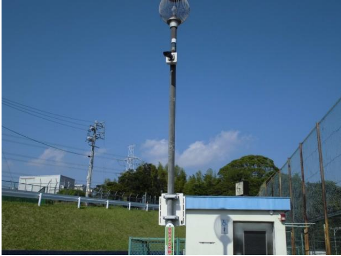
防犯カメラ設置工事（草木グラウンド・白沢グラウンド・板山グラウンド）
