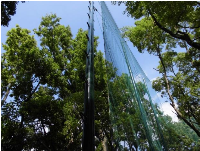
野球場三塁側ネット支柱塗装工事（全17本）
