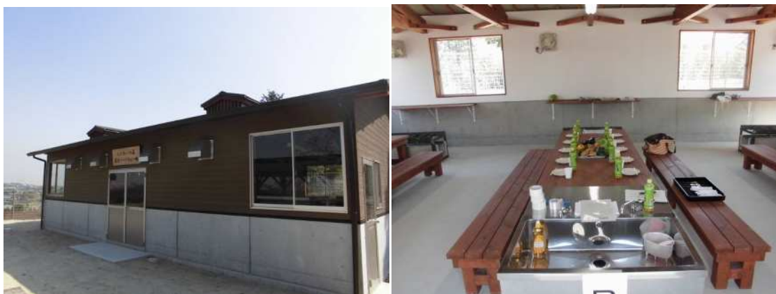
完成したふれあいの森屋内バーベキュー場
