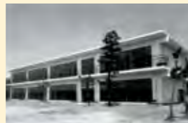
英比小学校鉄筋校舎完成/1961
