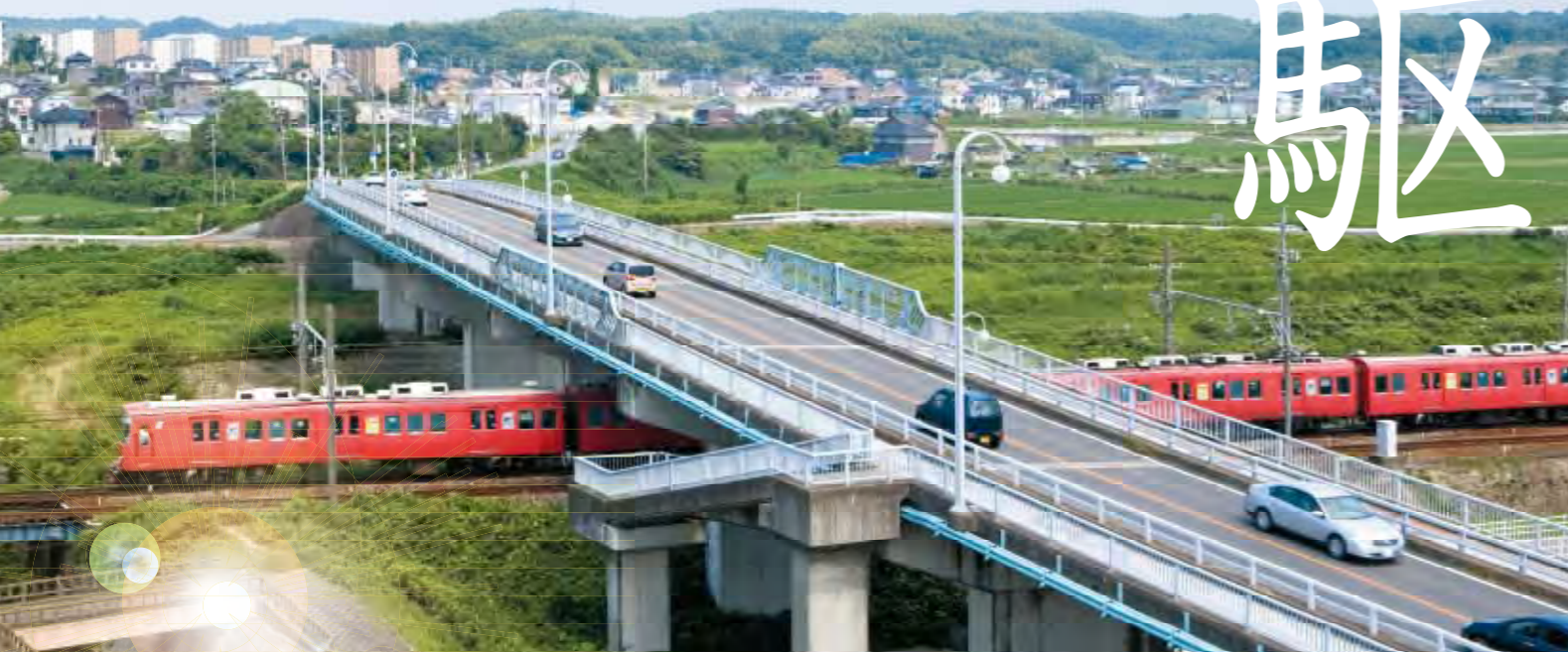
オアシス大橋 Oasis Ohashi (Bridge)
