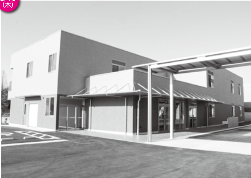
▲ 完成した増築校舎
