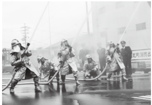
▲ 一斉放水の様子
