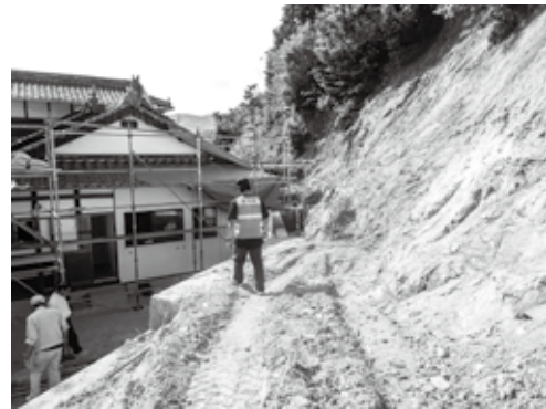
▲家の裏側 修復中の台所
