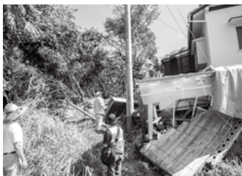
▲斜面が崩れ、塀・物置・給湯器が押し潰された家
