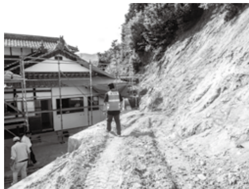
▲家の裏側 修復中の台所
