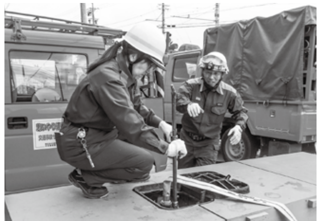
▲ 模擬消火栓を使用した放水訓練の様子
