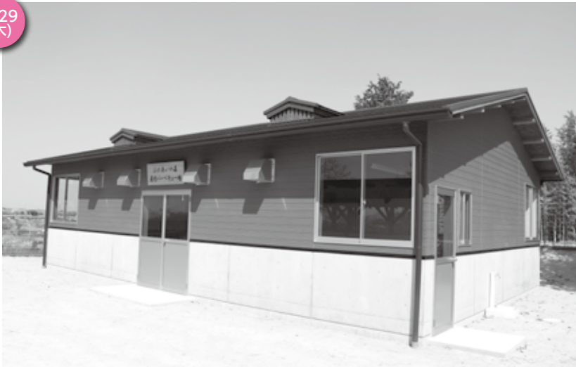
新しく完成した屋内バーベキュー場
