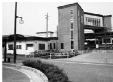
阿久比駅バリアフリー化工事完成 (6月1日)
