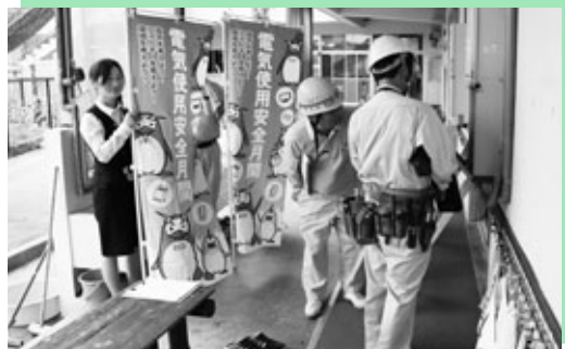
電気設備に不備がないか確認する組合員
