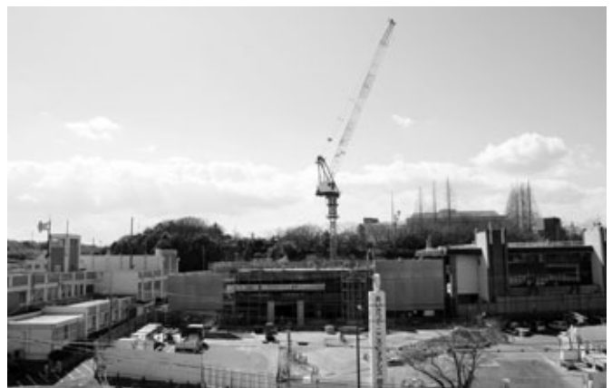
新庁舎建設現場の様子
