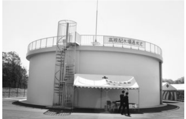
新しくできた高根配水場配水池
