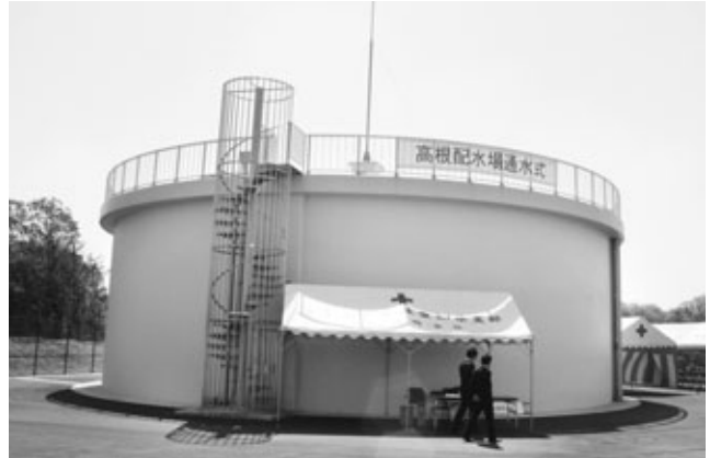
新しくできた高根配水場配水池
