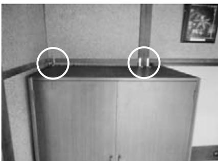
地震発生時の家具の転倒による死亡・負傷などを減らすため、対象となる世帯の家具転倒防止金具を無償で取り付けます。一世帯4点まで(洋服ダンスなど)となり、費用は町が負担します。
