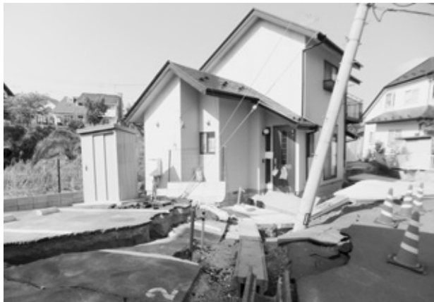
地割れがおき、傾いてしまった住宅
