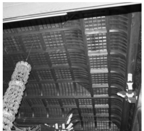
天井が膨らむ“格天井”
