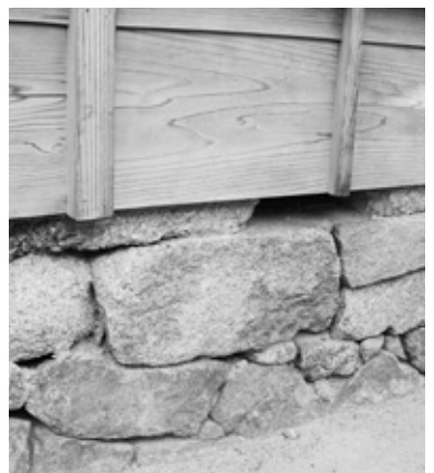
力二も迷い込んだ御影石が積まれた基礎
