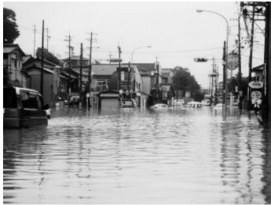
東海豪雨直後の坂部駅西交差点付近
