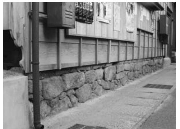
青年会場の基礎になっている「石垣」
