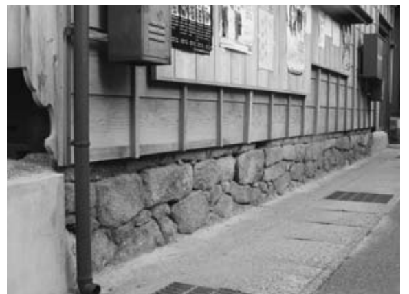
青年会場の基礎になっている「石垣」
