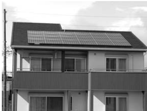
屋根の部分に取り付けられているのが太陽光発電システム
