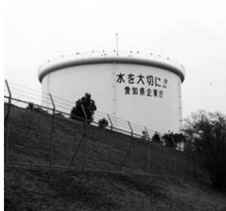
愛知県水道貯水施設の貯水タンク
