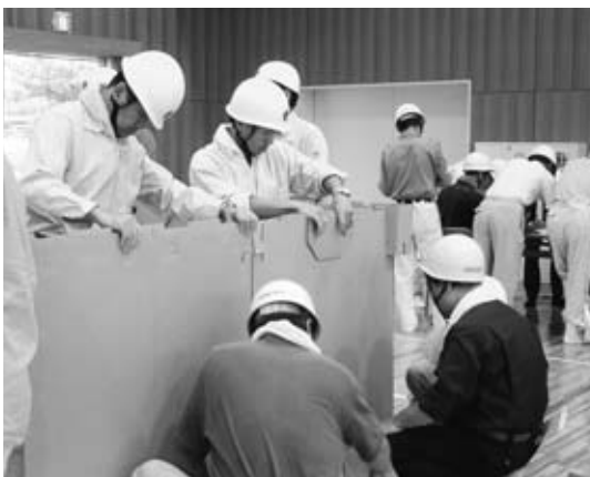
間仕切板の設営
