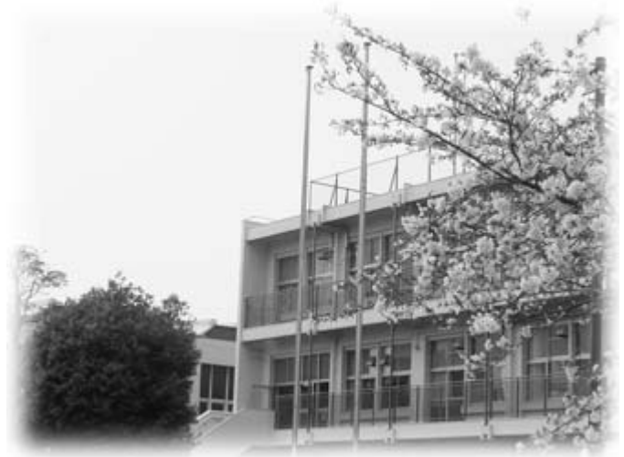
小学校耐震改修工事を行います。
