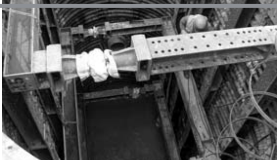
「草木汚水幹線」の下水道工事
